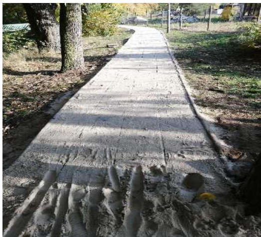
Fot. Zdjęcie przedstawia chodnik między kładką a ul. Parkową w trakcie remontu październik 2019 r.
