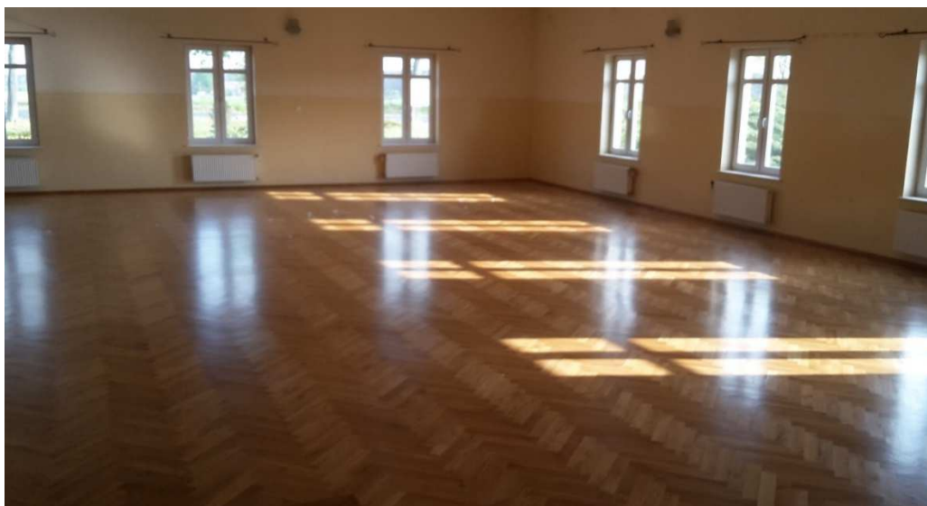
Fot. Zdjęcia parkietu na świetlicy w Guzowie po jego renowacji
