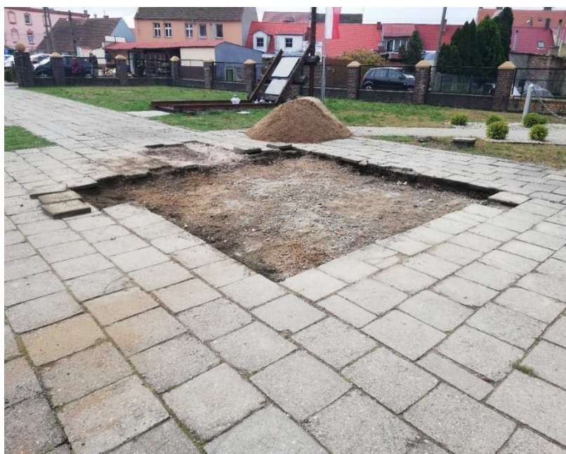
Fot. Zdjęcie w trakcie prac rozbiórkowych
