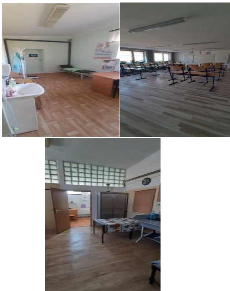
Fot. Remont jednego gabinetu lekcyjnego, pomieszczenia do wydawania posiłków, gabinetu pielęgniarki
