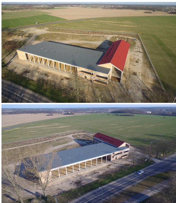
Fot. Nowa strażnica Komendy Powiatowej PSP
