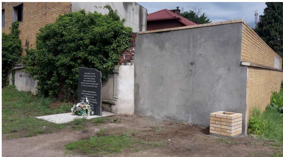
Fot. Zdjęcie przedstawia mur przy odbiorze prac remontowych
