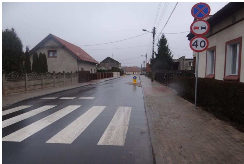
Fot. Ulica I Armii wraz z odwodnieniem po przebudowie
