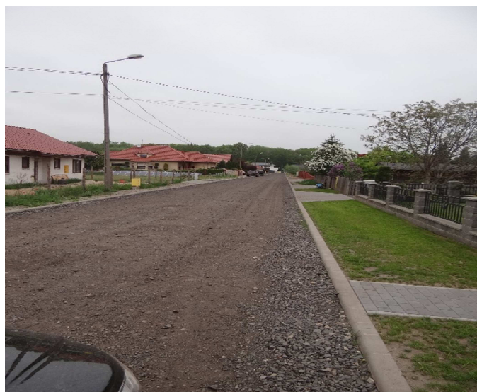
Fot. Remont ul. Budowlanych
