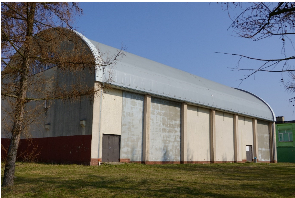
Fot. Przebudowa dachu hali sportowej
