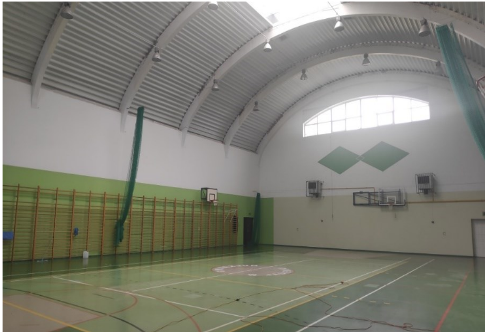
Fot. Przebudowa duchu sali gimnastycznej
