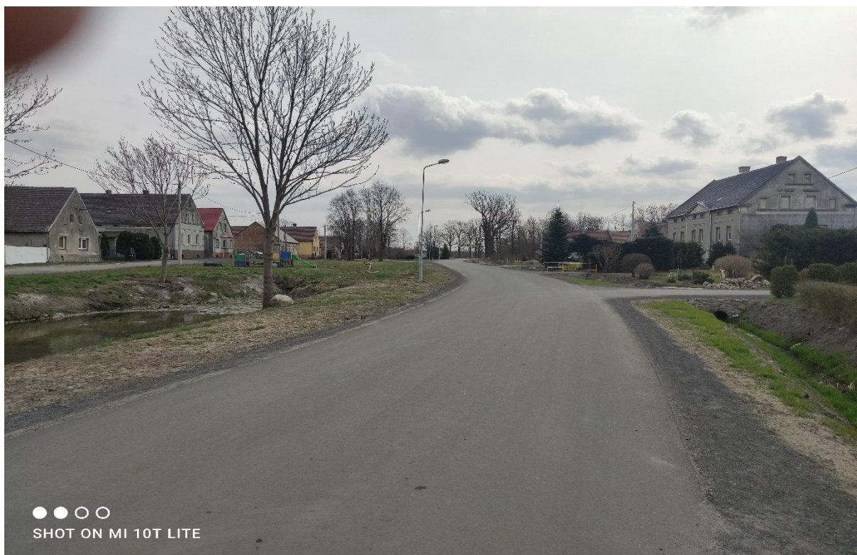
Fot. Przebudowana droga we wsi Jabłoniec
