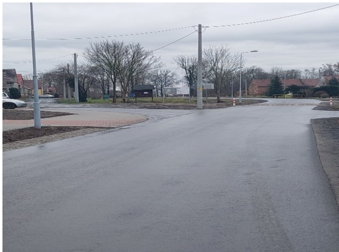
Fot. przebudowa drogi w miejscowości Jabłonec
