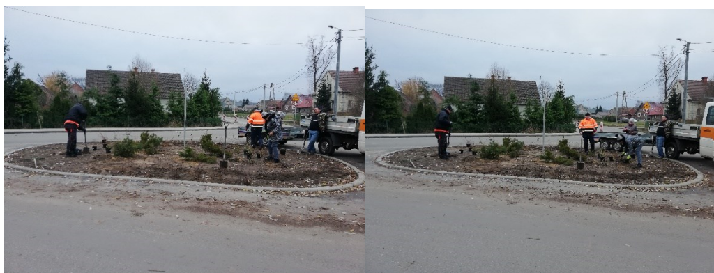
Fot. Realizacja nasadzeń krzewów w pasie drogi gminnej w Jabłońcu
