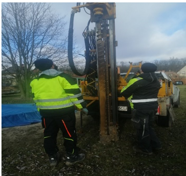
Fot. badania geologiczne pod budowę zbiornika retencyjnego
