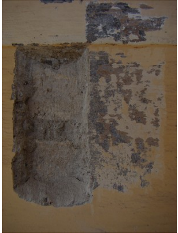
fot. 9: odkrywka na wyprawie tynkarskiej ściany, poniżej gzymsu koronującego po stronie wschodniej
