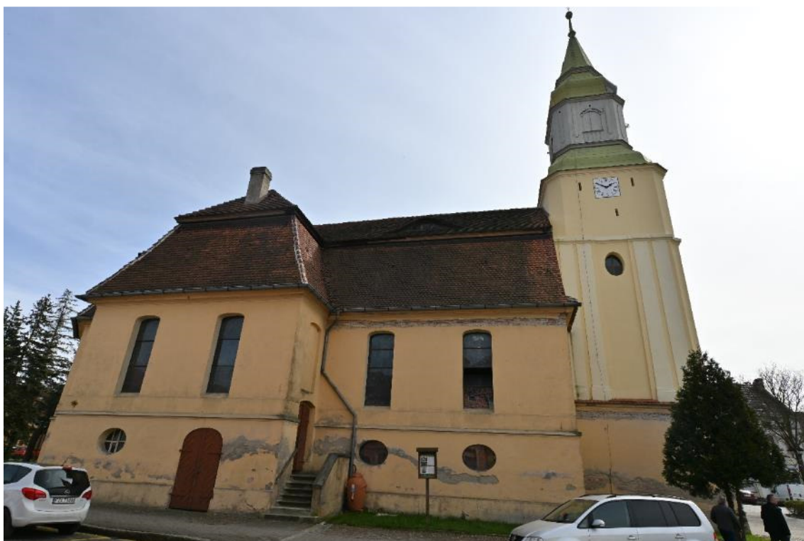
Fot. 2 Widok ogólny kościoła od strony północnej
