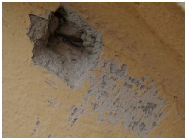
fot. 5: odkrywka poniżej profilu nad oknem mansardowym
