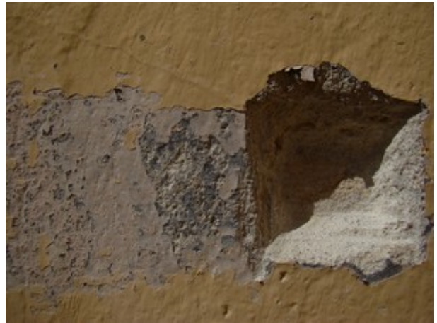
fot. 22: odkrywka na południowej elewacji nawy, widoczne ślady niebieskiej malatury
