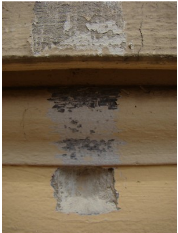
fot. 11: odkrywka na wyprawie tynkarskiej i profilu dolnego gzymsu obwodowego na południowej ścianie absydy
