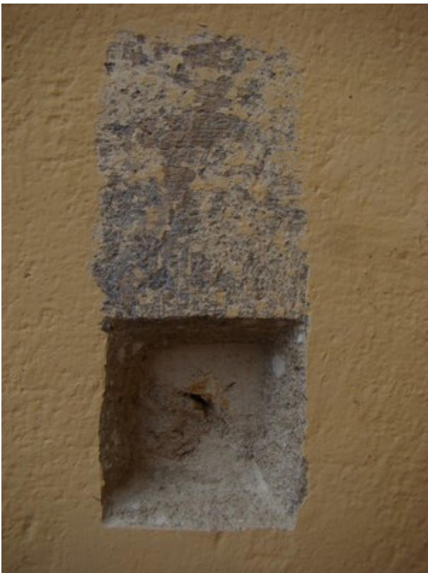
fot. 10: odkrywka na wyprawie tynkarskiej nawy po stronie południowej, ściana wschodnia
