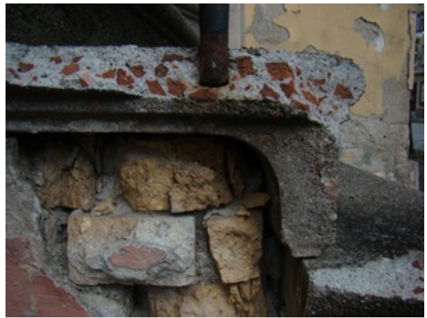
fot. 24: przełam na jednym ze stopni wejścia do transeptu, widoczne ceglane wypełnienie okruchami ceglanymi w masie prefabrykowanego odlewu stopnia
