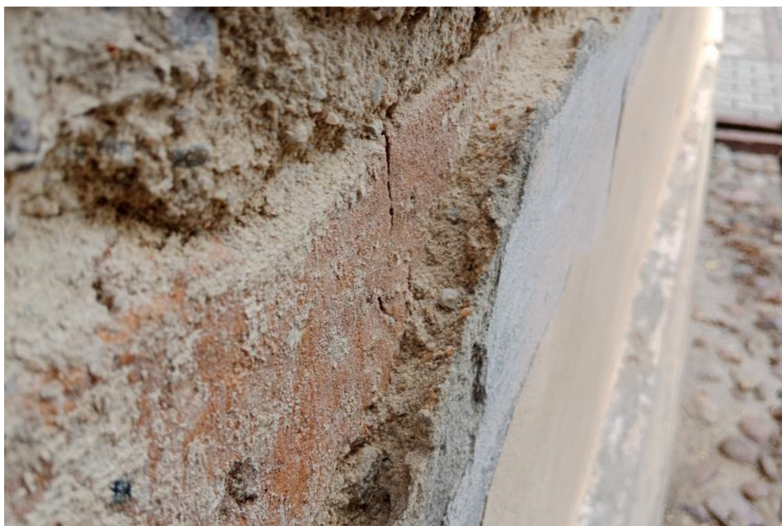
Fot. 16 Widoczne warstwy wypraw tynkarskich wprowadzonych na elewacji budynku
