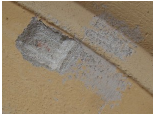
fot. 4: odkrywka w strefie profilu nad oknem mansardowym
