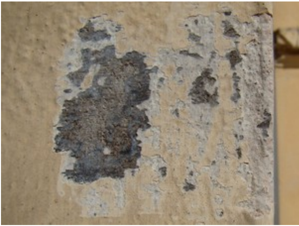
fot. 21: odkrywka malatur w ościeżu dolnego, owalnego okna południowej elewacji nawy, widoczne ślady niebieskiej malatury
