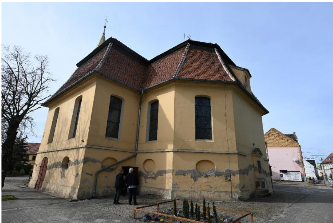
Fot. 3 Widok ogólny kościoła od strony południowo-wschodniej
