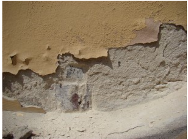
fot. 13: odkrywka w zamurowanym jednym z okien prezbiterium, strona południowa
