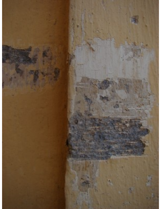
fot. 17: odkrywki na północnej ścianie wieży (po lewej) i lizenie (po prawej)
