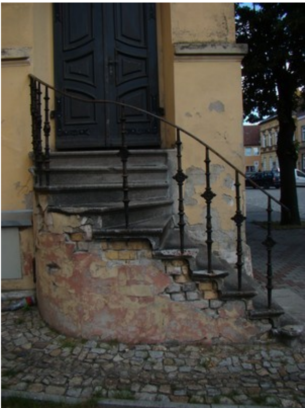
fot. 23: schody z prefabrykowanych cementowych stopni, prowadzące do zachodniego wejścia w południowej części transeptu
