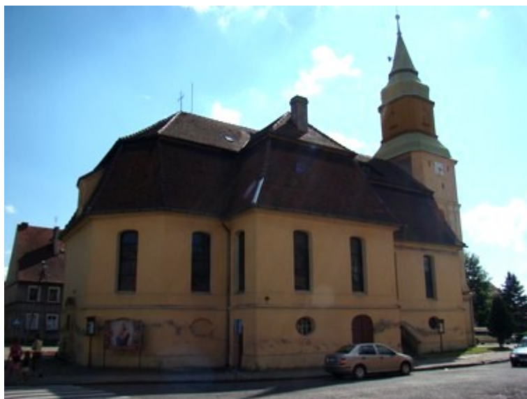
fot. 2: widok kościoła od strony północno-wschodniej, wyraźna linia poziomu wysychania zawilgoconej, dolnej partii muru rysująca się na poziomie około 2m, poniżej dolnego gzymsu obwodowego
