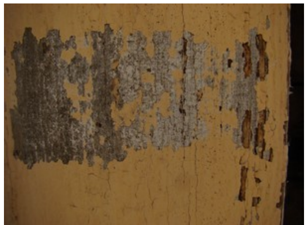
fot. 7: odkrywka na drewnianej części profilu gzymsu koronującego po stronie wschodniej, spód
