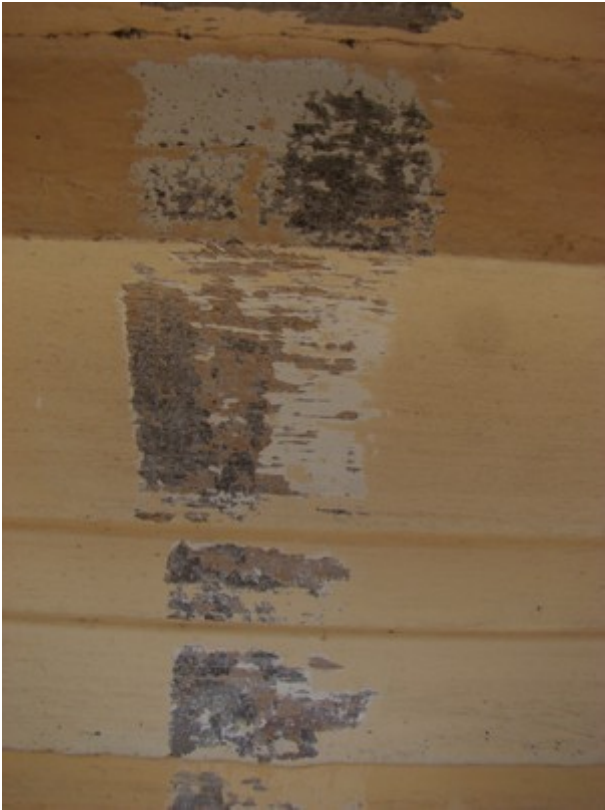
fot. 8: odkrywka na wykonanej w zaprawie części profilu gzymsu koronującego po stronie wschodniej
