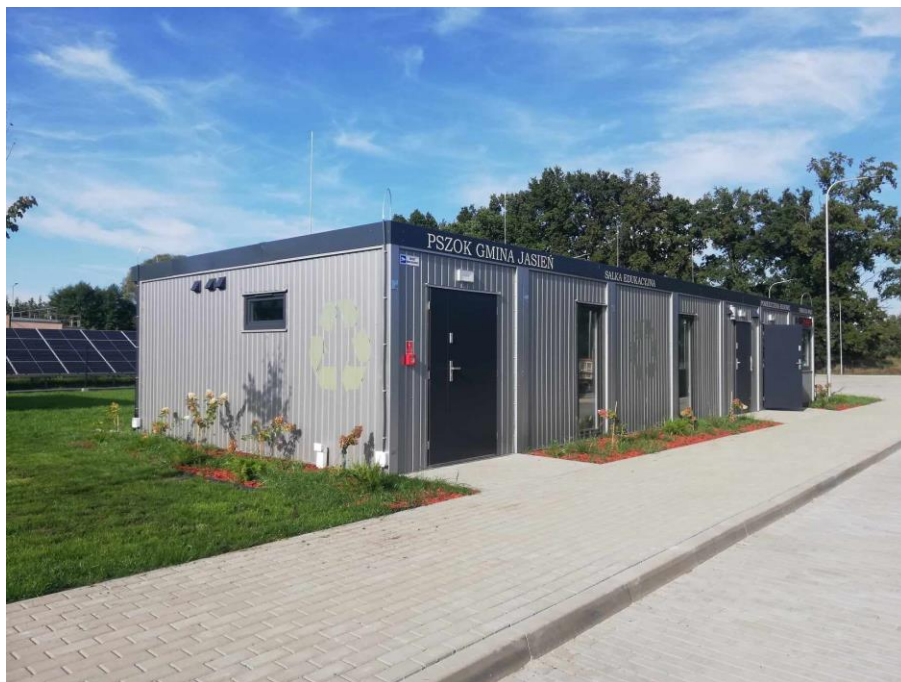
Ryc. 1 Punkt Selektywnej Zbiórki Odpadów Komunalnych, ul. Zielonogórska 3, 68-320 Jasień
