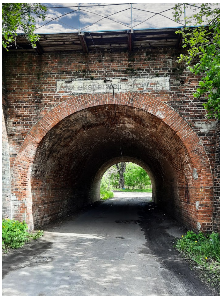
Przepust kolejowy w Jasieniu
