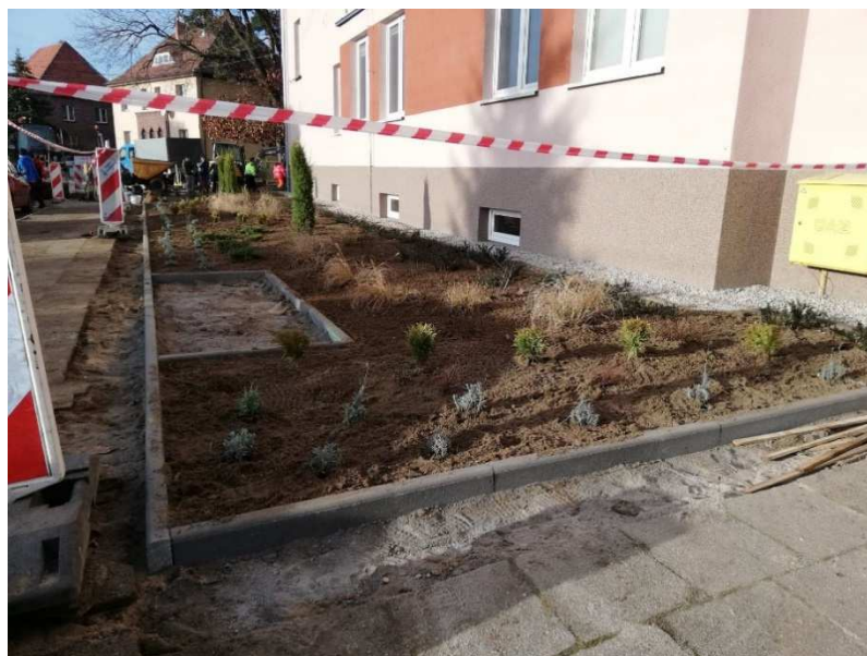
Fot. Teren w trakcie realizacji przy ul. Okrzei w Jasieniu
