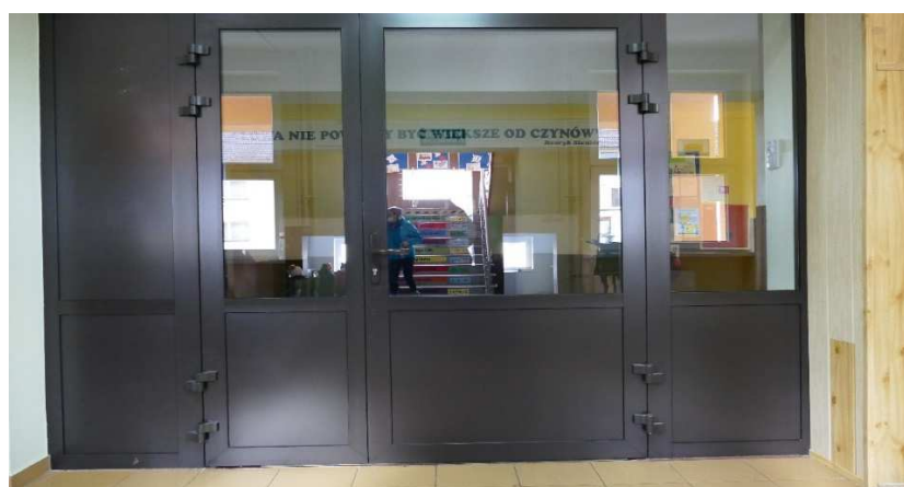
Fot. Nowe drzwi
