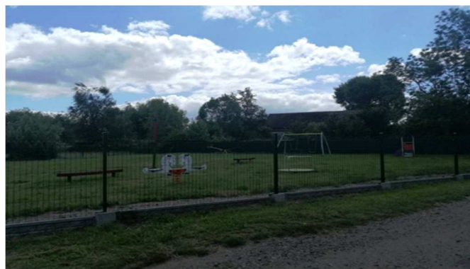
Fot. Zabłocie – ogrodzenie placu zabaw – 4 007,40 zł
