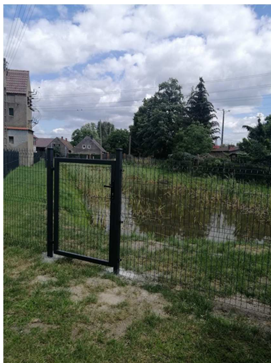
Fot. Wykonanie ogrodzenia wokół stawu w miejscowości Budziechów
