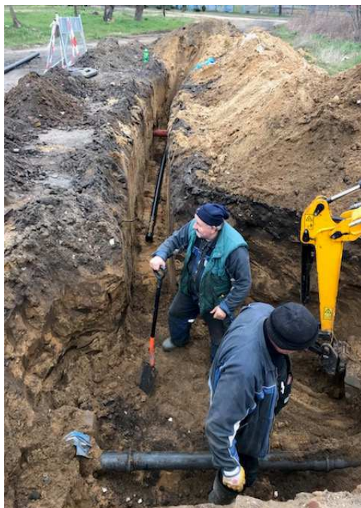
Fot. Budowa przyłącza wodociągowego do boiska w miejscowości Jabłonec
