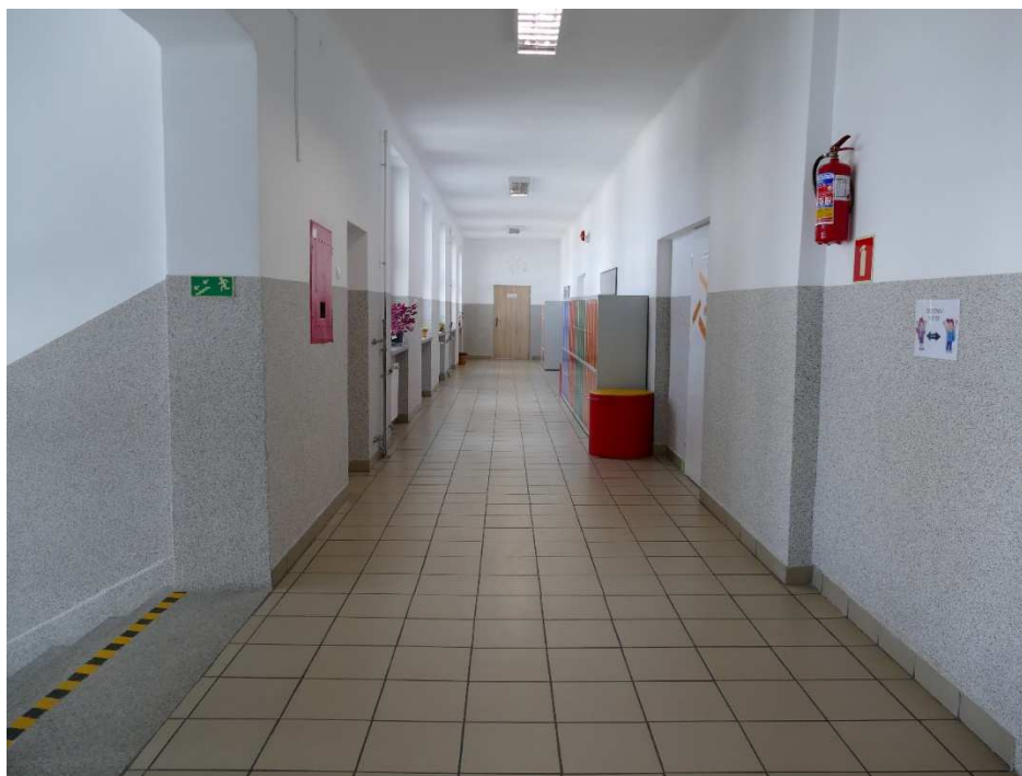
Fot. Remont korytarza
