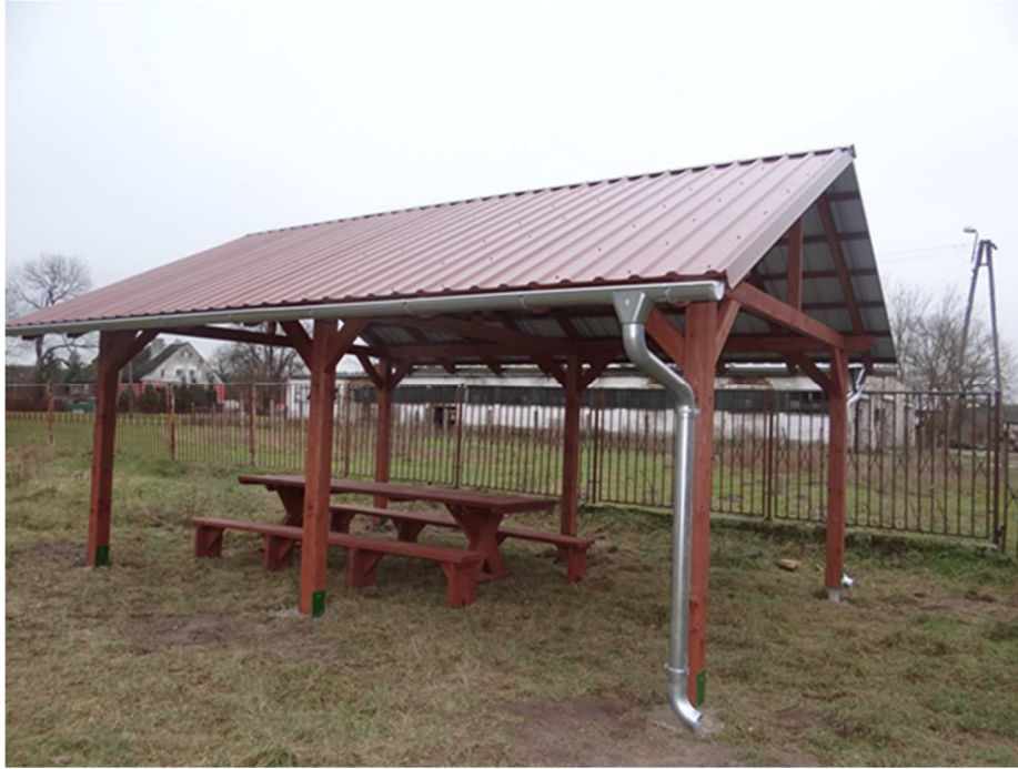
Fot. Altana rekreacyjna z wyposażeniem na placu zabaw w miejscowości Mirkowice
