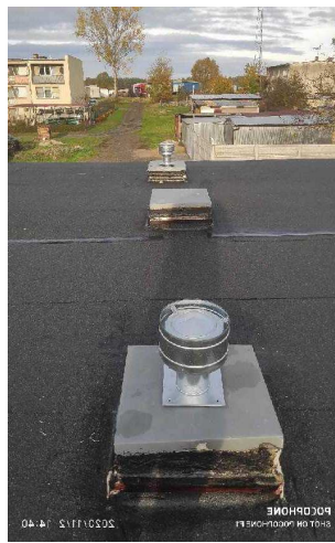
Fot. Dach w świetlicy wiejskiej w Jaryszowie
