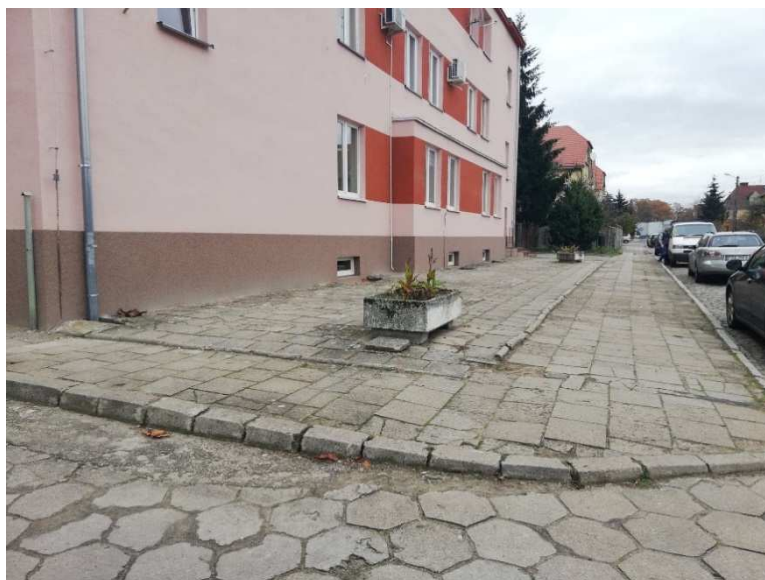
Fot. Teren przed budową terenu zieleni przy ul. Okrzei
