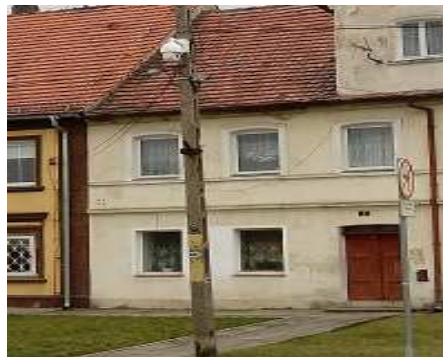
Fot. Monitoring w mieście
