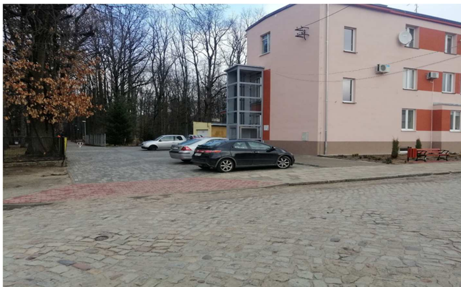
Fot. Modernizacja placu z wykonaniem miejsc postojowych i utwardzeniem przyległego terenu w m. Jasień ul. Okrzei
