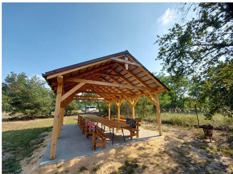
Fot. I etap budowy altany na placu zabaw w miejscowości Roztoki
