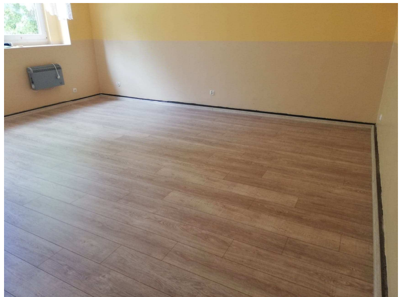
Fot. Podłoga w świetlicy wiejskiej w Świbnej.
