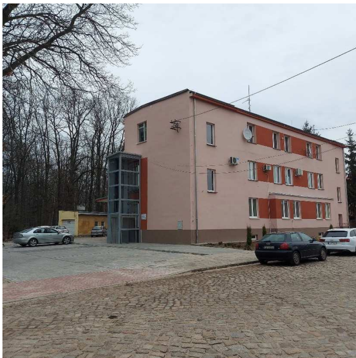
Fot. Winda dla osób niepełnosprawnych przy budynku Ośrodka Zdrowia w Jasieniu
